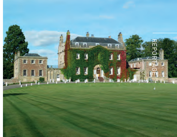
Culloden House, en historisk byggnad och ett hotell med mycket personlighet. Hit vill vi återvända!
